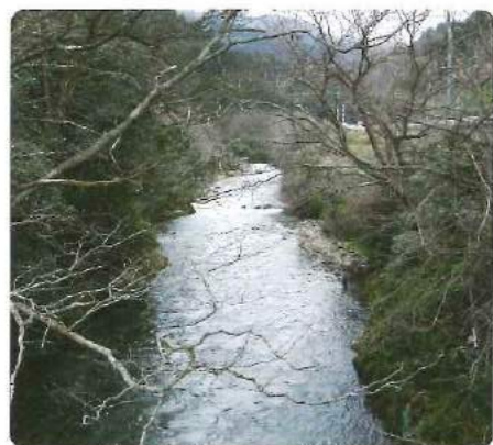
つく谷橋より上流を望む
